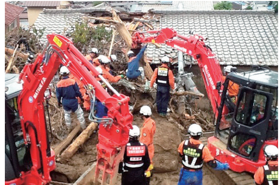
重機による活動(岡山市消防局提供)
